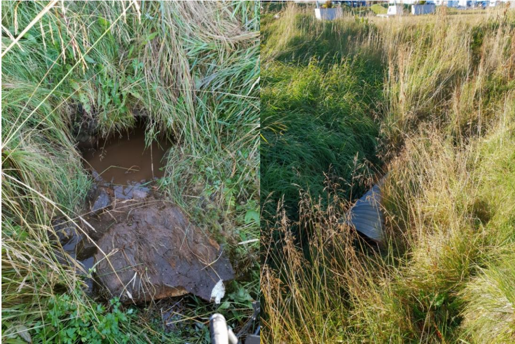
Mynd 5 Ræsi undir Breiðamýri sem tengir svæði 2 og 1. Inntak til vinstri og útrás til hægri.
