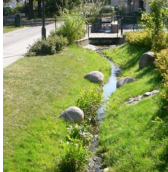
Mynd 8 Mynd til vinstri frá Alta: keðja ofanvatnslausna. Mynd til hægri: Dæmi um ofanvatnsrás
