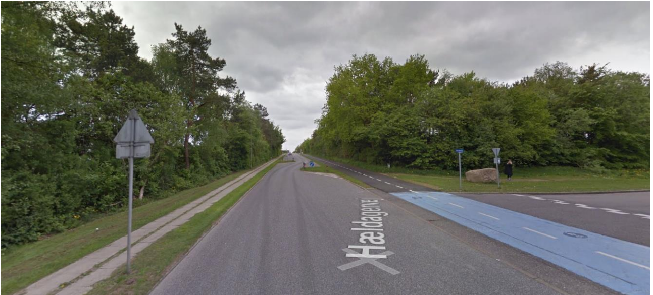
Mynd 9-2 Dansk dæmi sem sýnir vegþrengingu á beinum og breiðum vegi og göngu- og hjólastíga meðfram.
