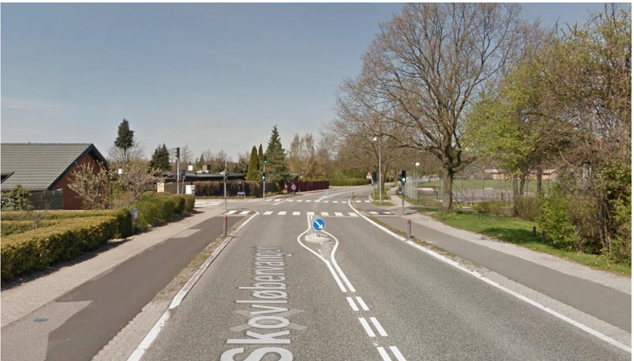
Mynd 8-5 Dæmi um gatnamót með gangbrautum og gönguljósum ásamt miðeyju til að hægja á umferð.
