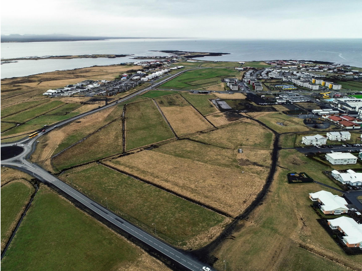
Mynd 9 Horft yfir skipulagssvæðin. Fremst á myndinni er svæði 1 Breiðamýri.
