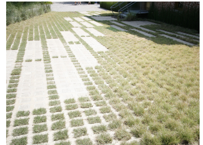
Mynd 13 - Gegndræpt yfirborð
