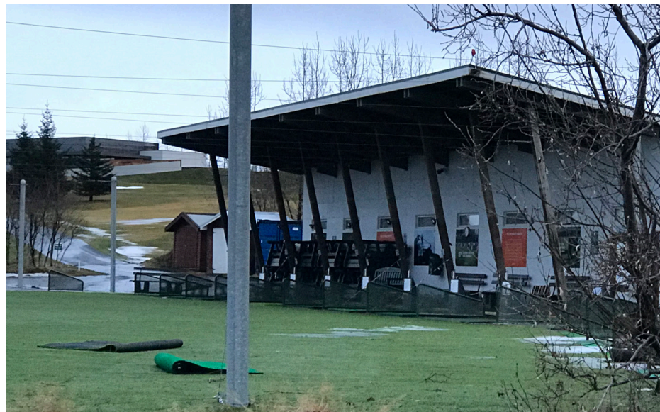
véla- og verkfærageymsla við Vetrarbraut 2
