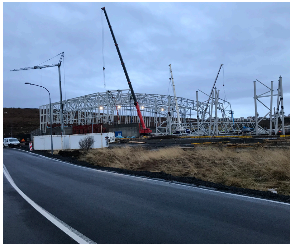
fjölnota íþróttahús í byggingu skv. eldra skipulagi
