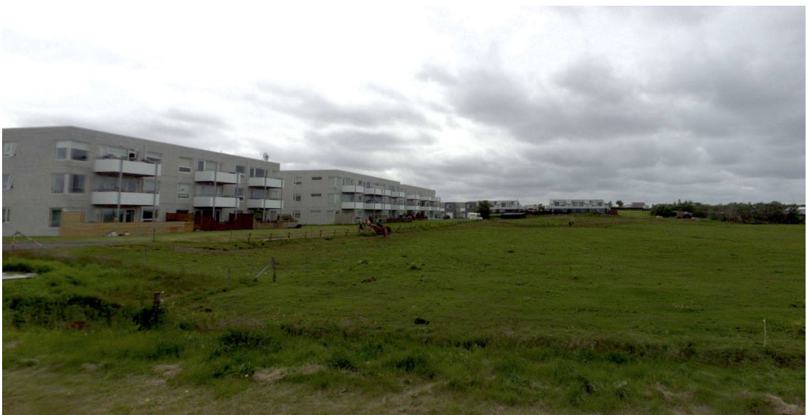
Mynd 4. Horft yfir svæðið til suðvesturs að fjölbýlishúsum við Asparholt (tekið af Google).
