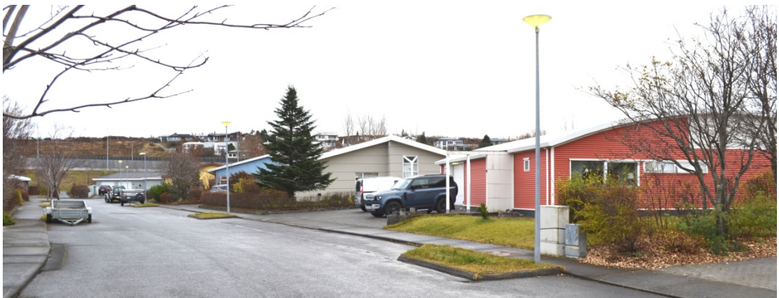
Hús við Urðarhæð. Í fjarska hús í Hnoðraholti, austan Reykjanesbrautar
