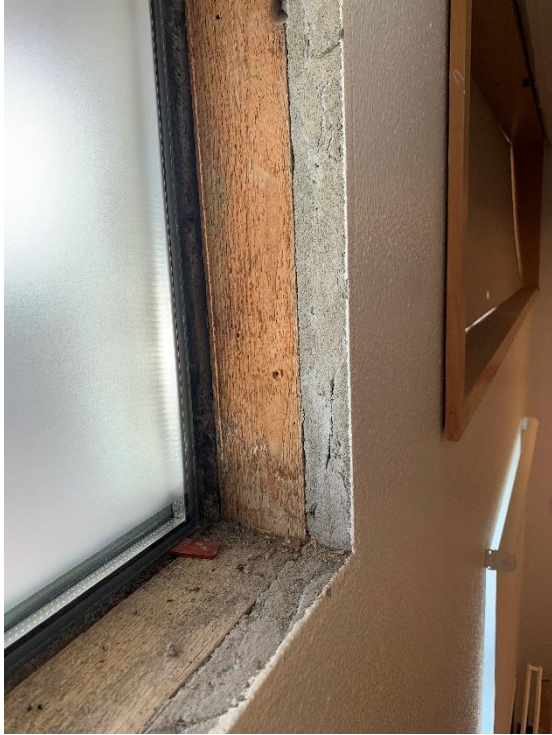
Mynd 9, Hægra neðra horn, ummerki eftir raka í timbri
