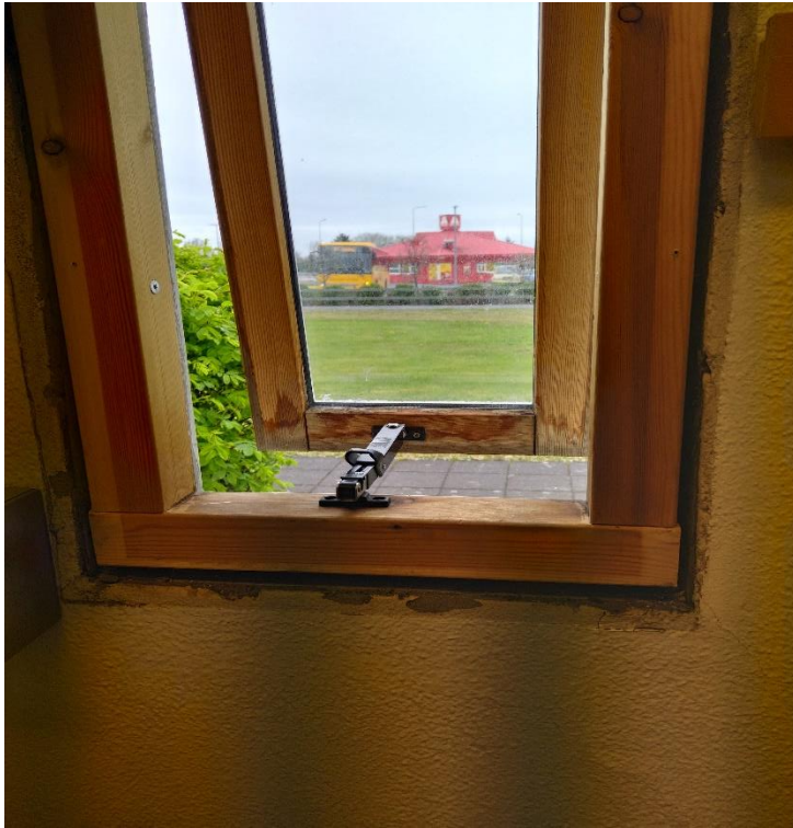
Mynd 1 Vöntun á þéttingu, til að varna slagamyndun bakvið útkítta
