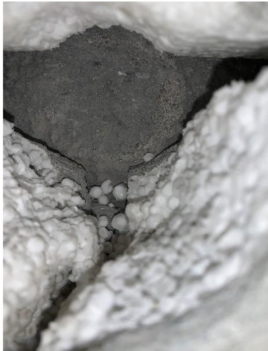
Mynd 12. H2 vinnuherb. ens/dan sama borgat og á mynd 11. séð í útvegg. ATH. það er hreyfing á lofti inni vegg.
