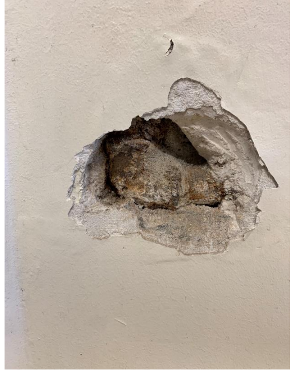
Mynd 16. Náttúrfraeði eftir borun ryðgað rör við vask.
